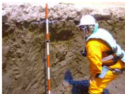
立坑壁面観察状況
