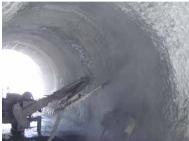
低アルカリ性コンクリート材料の施工試験例 (模擬トンネルへの吹付け試験)
