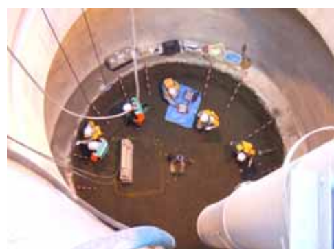
立坑壁面観察・計測状況
