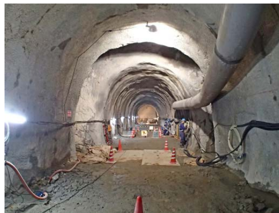
深度500m研究アクセス北坑道(冠水坑道)
