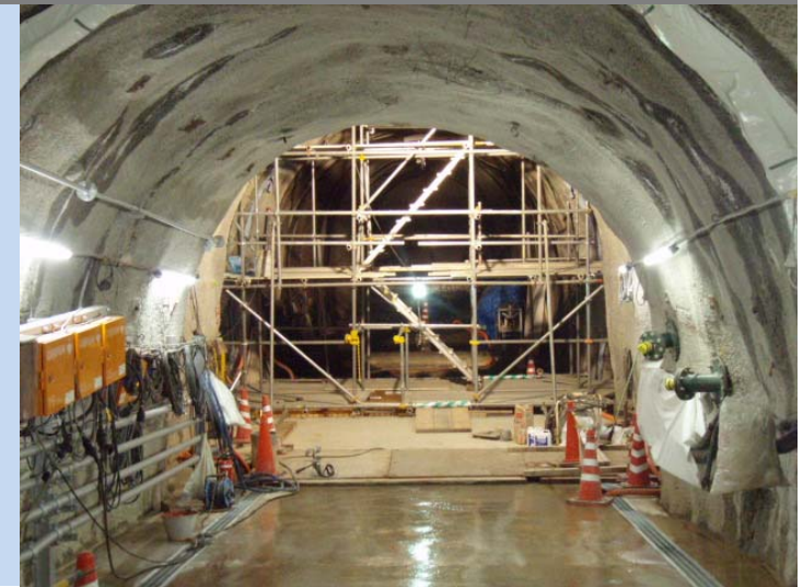
止水壁設置作業現場の状況 （11月26日現在）
