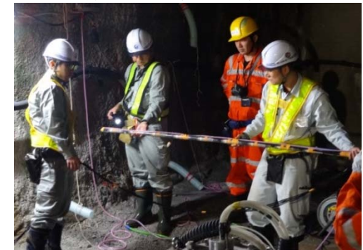
ハイドロフォン設置作業
