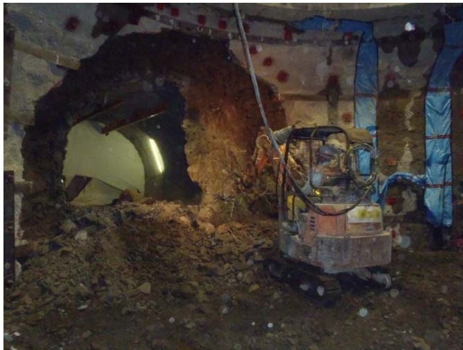
平成24年9月10日、西立坑と深度140m調査坑道が貫通
