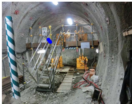
深度350m調査坑道 (平成24年8月24日撮影)
