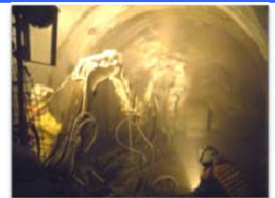
吹付け施工状況 (140m調査坑道)
