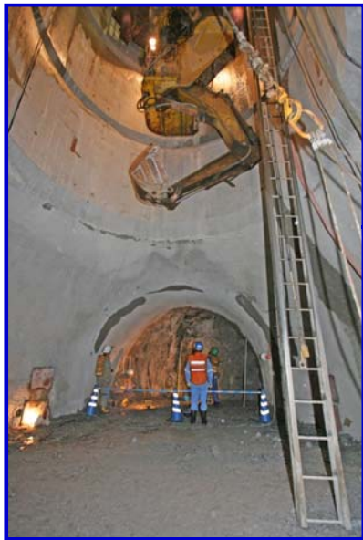
換気立坑(深度500m)
