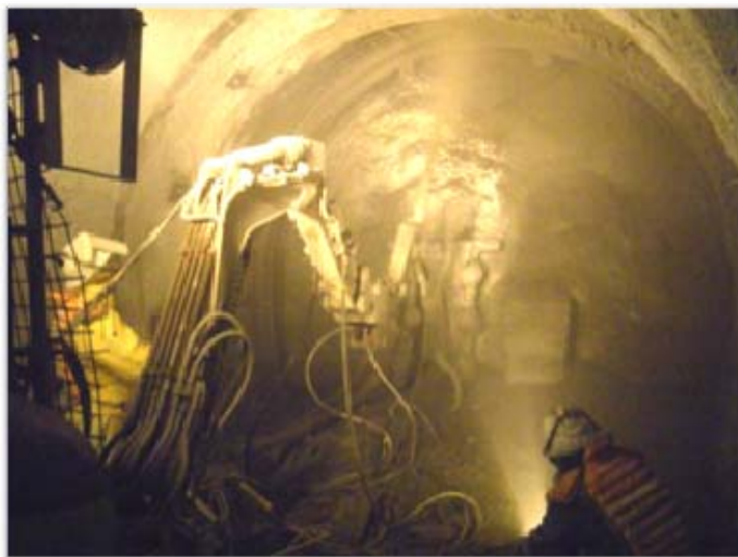
吹付け施工状況（140m）
