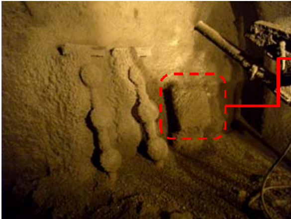
型枠への吹付け状況
