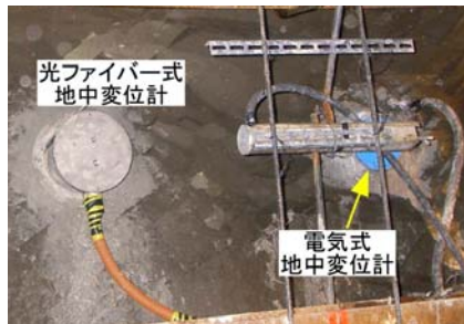
立坑の岩盤への設置状況 (右上：アンカー設置状況)
