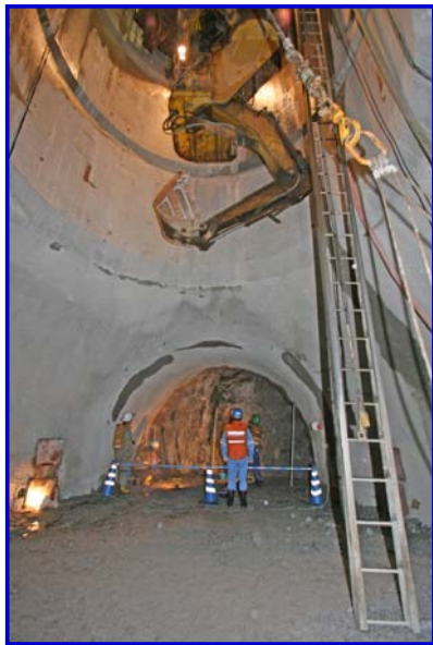
換気立坑( 深度500m )
