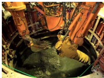
換気立坑掘削工事 (H23.8.23)
