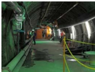
140m調査坑道
