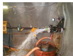
先行ボーリング時の湧水 (約1000ℓ/min)
