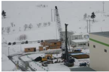
西立坑掘削工事(H23.2.25)
