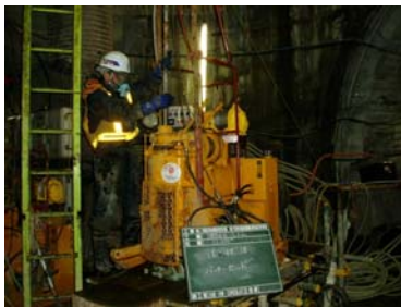
250m以深の立坑プレグラウト (換気立坑:H23.2.28)
