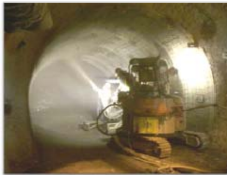
吹付け施工状況（140m調査坑道）
