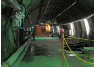
140m水平坑道
