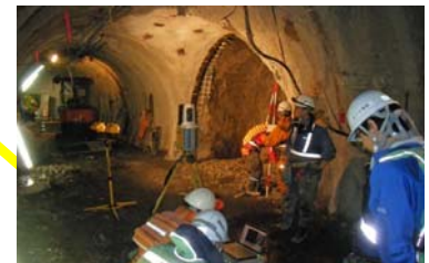
250m水平坑道 (ポンプ座の掘削:H23.2.4)
