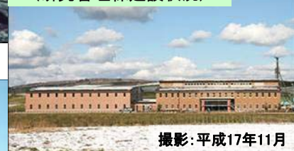
地上施設用地 (研究管理棟建設状況)
