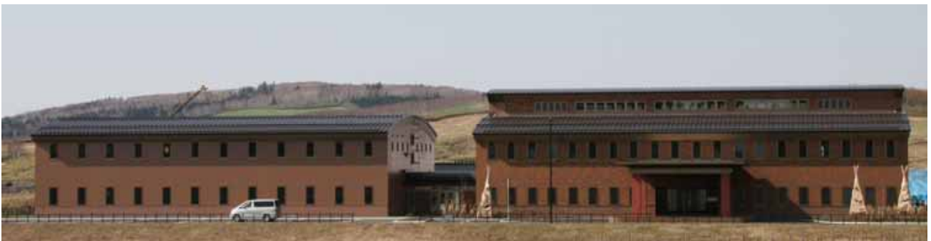
研究管理棟と試験棟 (平成18年5月9日撮影)
