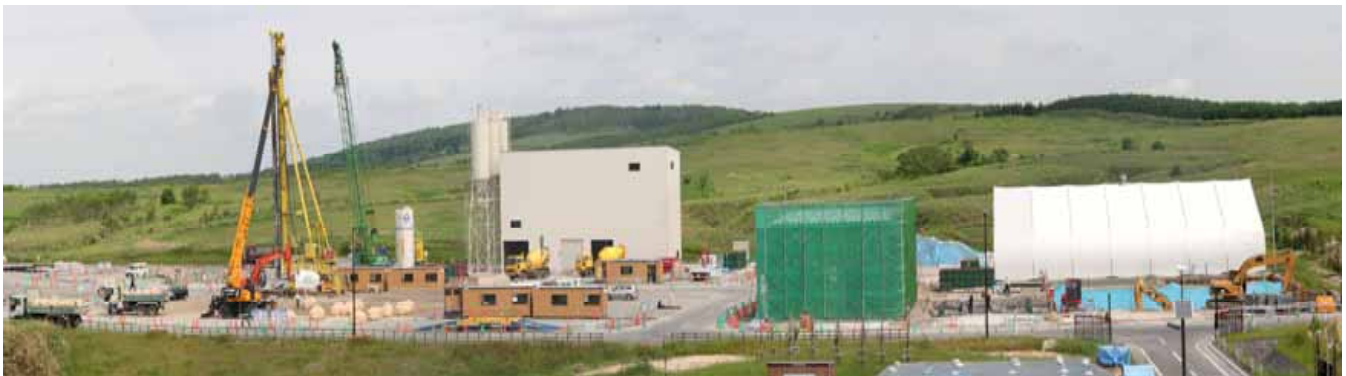
地下施設建設の状況(平成18年7月6日撮影)
