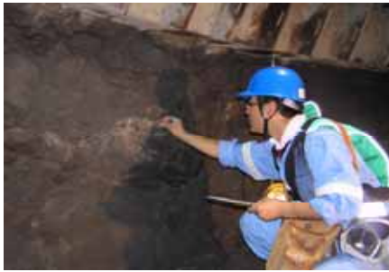
瑞浪超深地層研究所の例 立坑壁面観察状況
