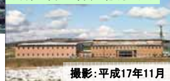
地上施設用地 (研究管理棟建設状況)
