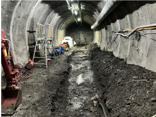
500m試験坑道9
