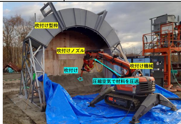
埋め戻し材の吹付け時の様子
