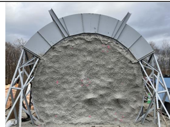
止水プラグ材料の吹付け完了時の様子
