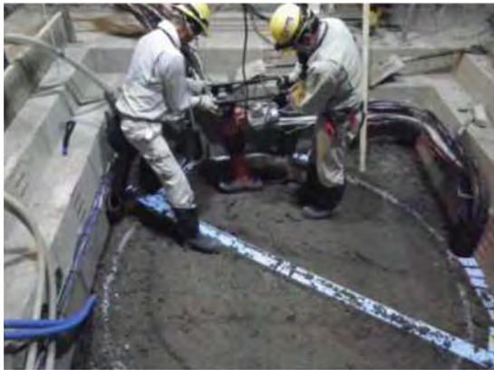
(a) ランマーによる締固め
