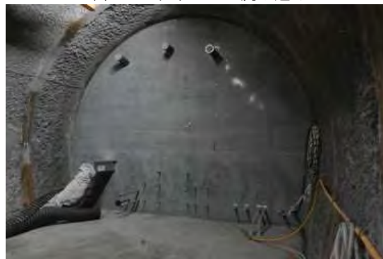
(d) 打設完了
