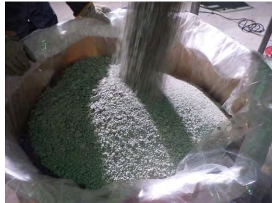
図 4.2.2.1-11 西立坑地上建屋における充填材料（ベントナイト混合土）の製造
