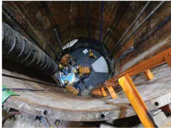
図 4.1.1.3-6 緩衝材ブロックの定置作業
