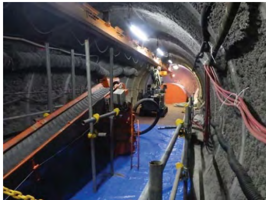
図 4.2.2.1-12 試験坑道 2 における伸縮アーム装置による吹付け試験の様子
