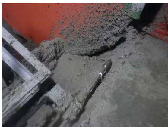
図 4.2.2.1-24 トルネードノズル（左）と配管洗浄ノズル（右：2 往復目）による充填材の除去
