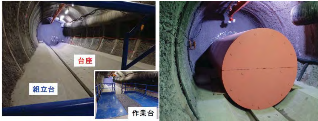
(b) 整備後の状況
