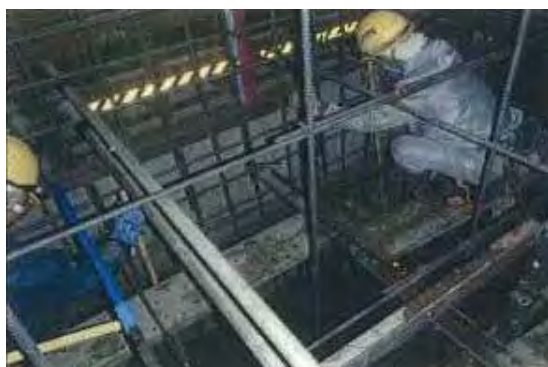
(a) 型枠内部
