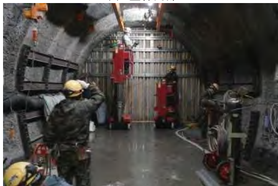
(c) 型枠解体
