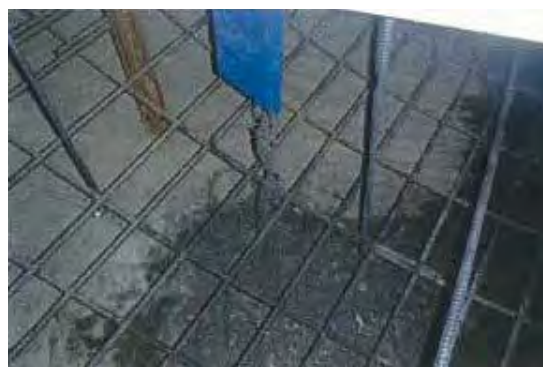
(b) コンクリートの流し込み
