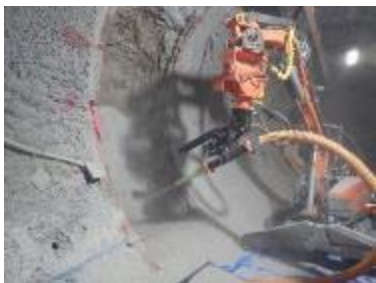
原位置吹付け試験の状況
