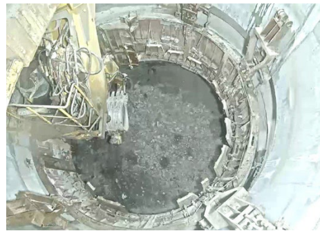
換気立坑 深度500m到達 (R7.1.22)
