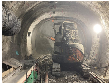
深度500m東連絡坑道の掘削 (R6.12.20)
