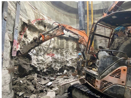
深度500m坑道掘削開始 (R6.9.17)
