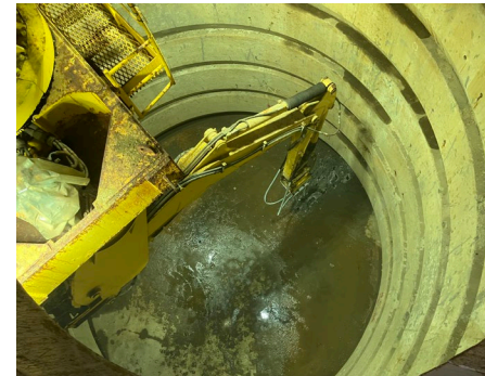
西立坑 深度365m掘削開始 (R6.9.11)
