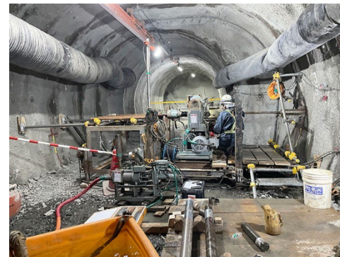
先行ボーリング掘削の様子
