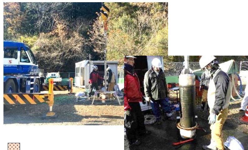
ケーシング・パッカー引き抜き
