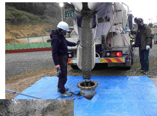
モルタル打設
