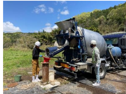
モルタル打設
