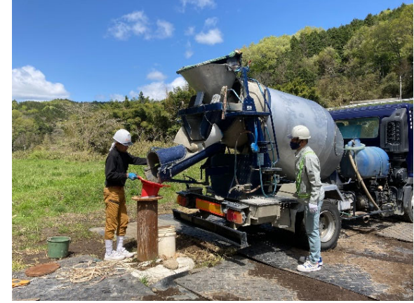
モルタル打設
