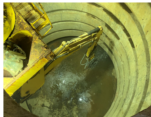
西立坑 深度365m掘削開始 (R6.9.11)
