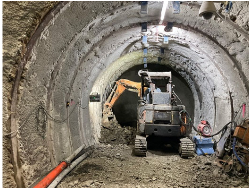
深度500m坑道の掘削 (R6.9.30)
