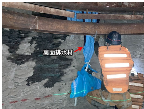
換気立坑 深度461m (R6.10.4)
