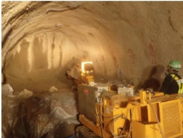
埋め戻し試験の様子(右は3Dスキャナーによる出来型計測)
