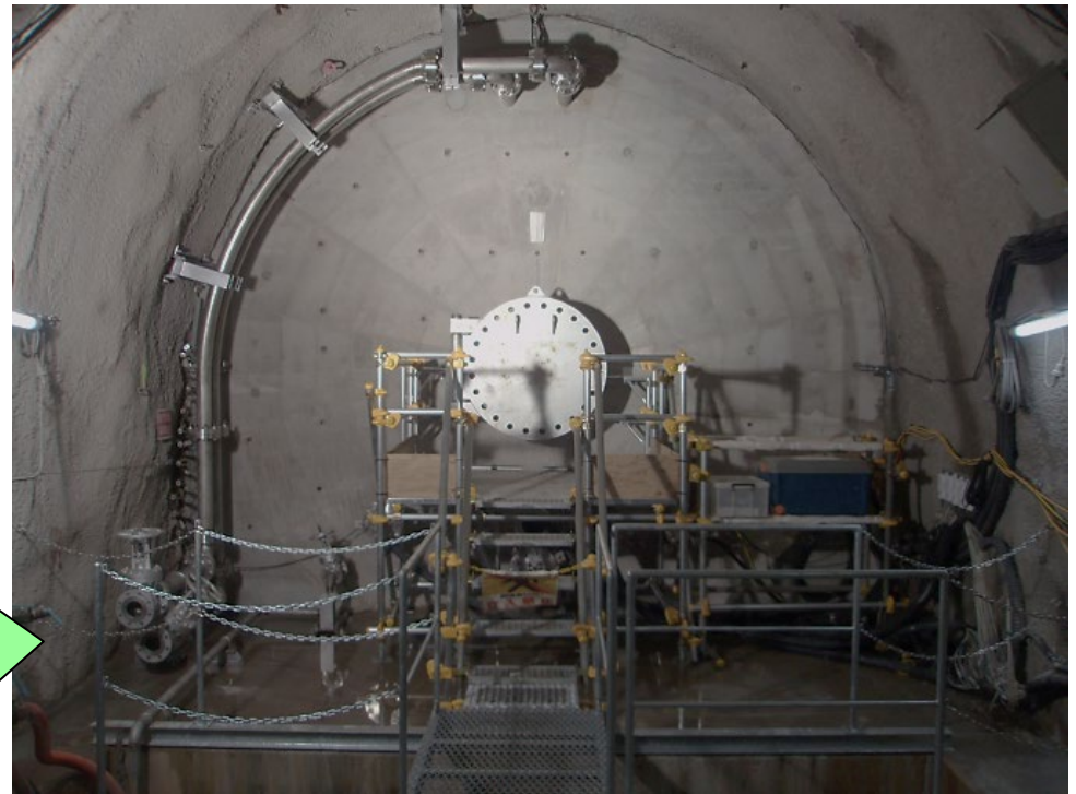
冠水坑道前の止水壁
