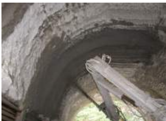
図 4.2-2 吹付けコンクリートの模擬施工状況
