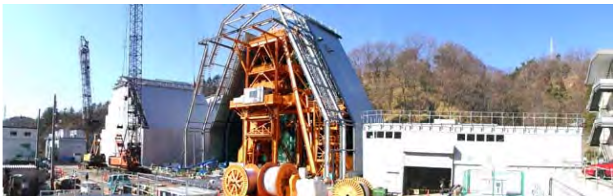
図 5.2.3-4 檣・防音ハウスの構築状況 (2004年12月28日撮影)
