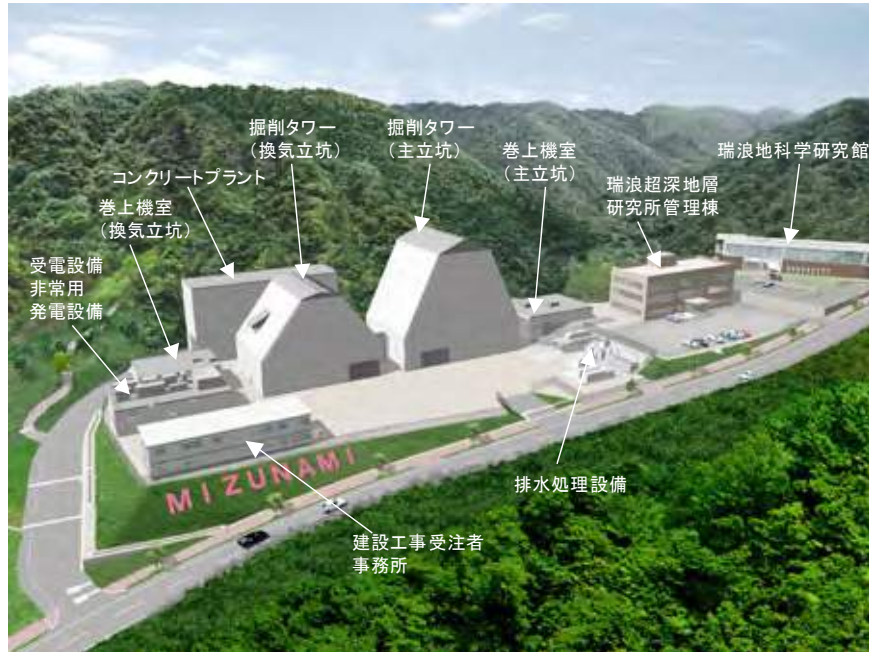
図 5.1.3-1 地上設備の配置
