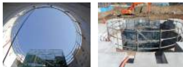
図 3.3.3-3 立坑坑口上部工の状況（完成）
