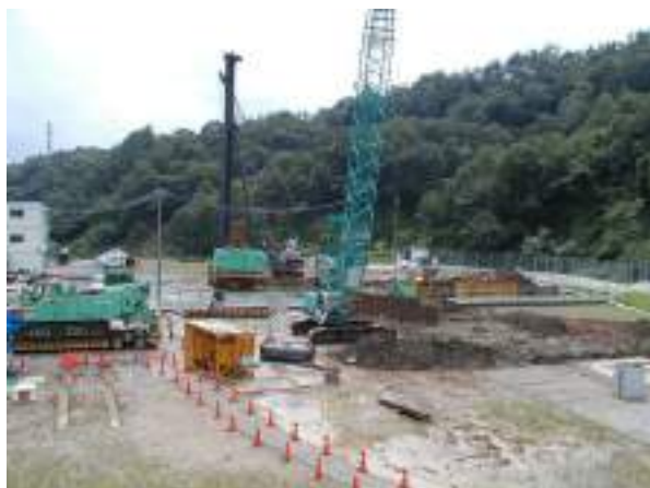
a) 土留め工（親杭打設）の状況
