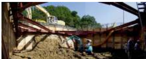
b) 掘削の状況
