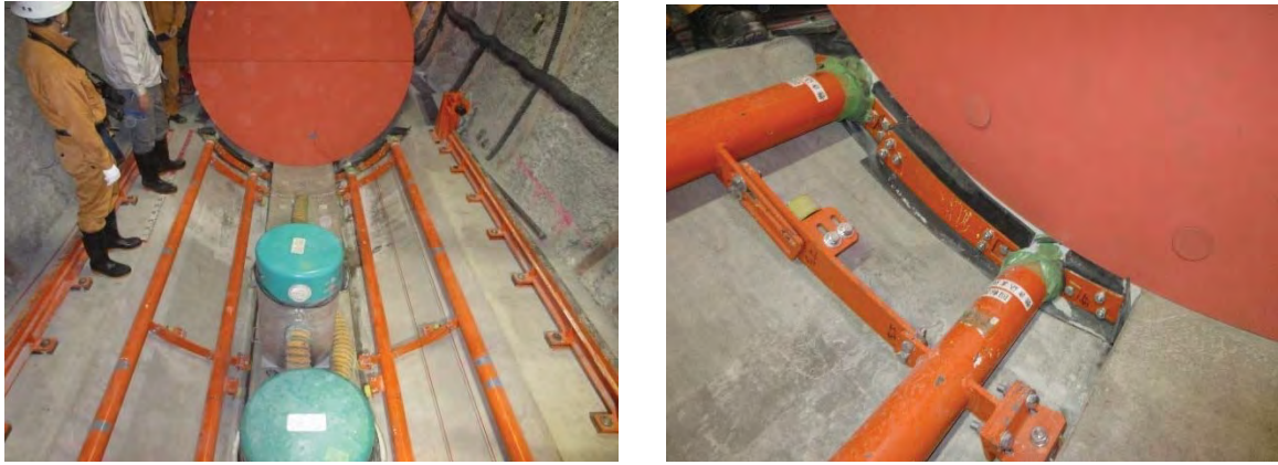
図 4.2.2.1-9 試験坑道 2 におけるペレット充填試験の様子
