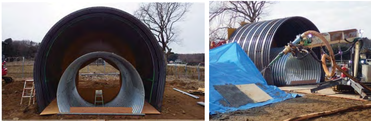
図 4.2.2.1-10 地上での模擬土槽に対する吹付け予備試験の様子
