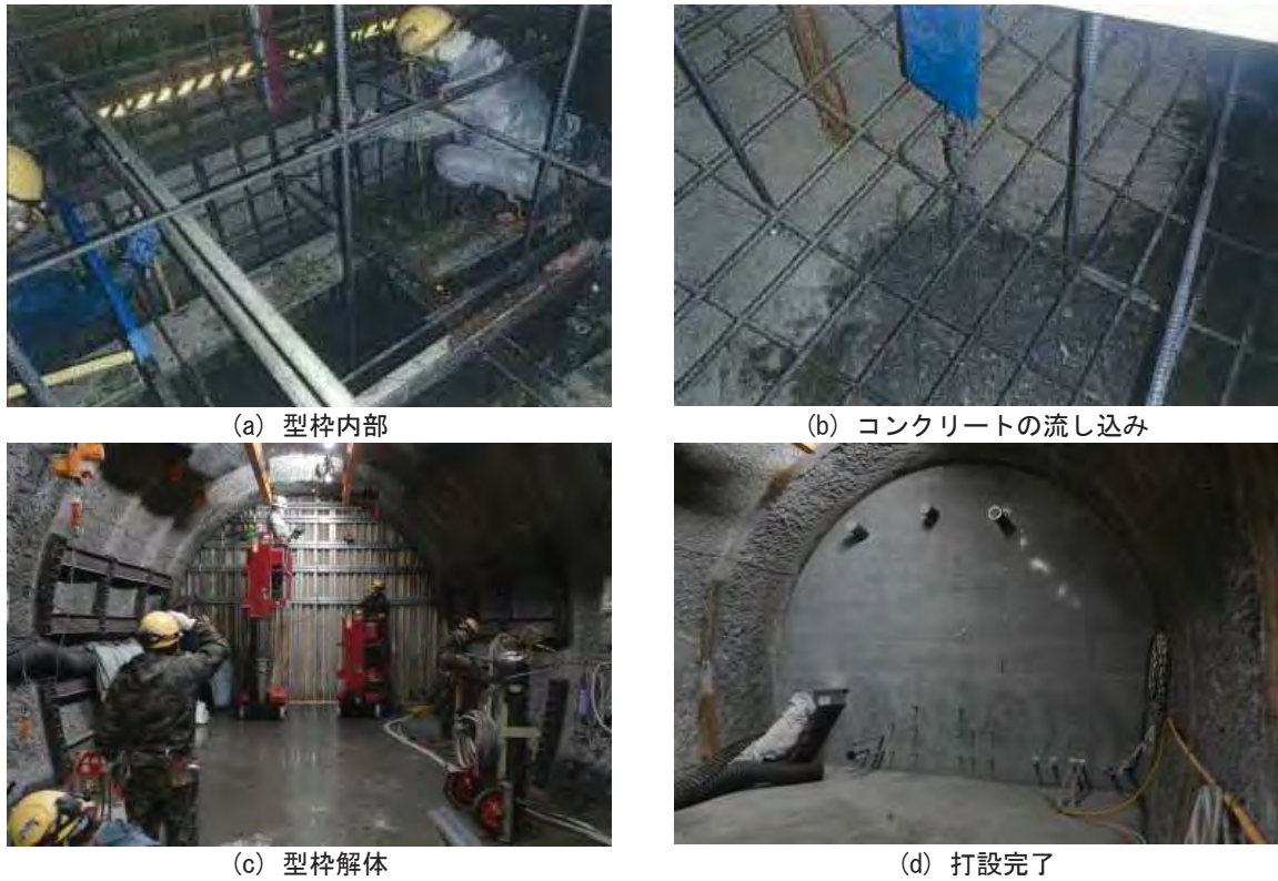
図 4.1.1.4-5 プラグコンクリートの施工状況
