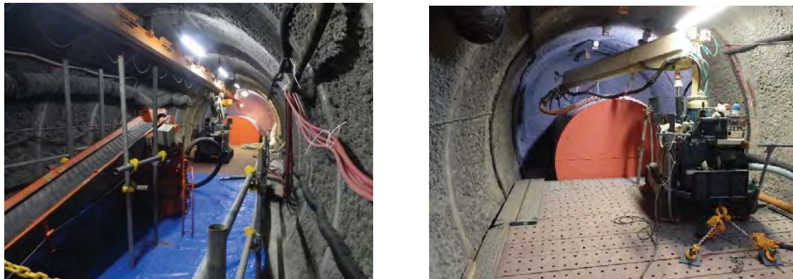
図 4.2.2.1-12 試験坑道 2 における伸縮アーム装置による吹付け試験の様子
