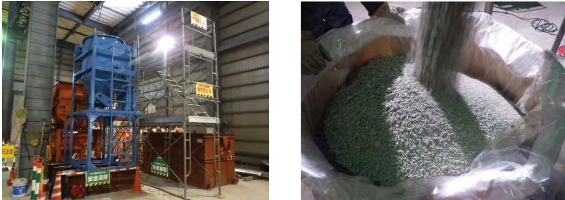
図 4.2.2.1-11 西立坑地上建屋における充填材料（ベントナイト混合土）の製造
