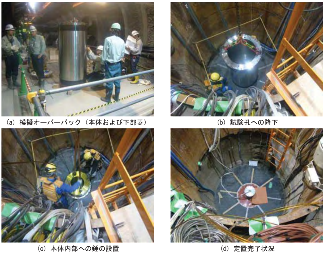
図 4.1.1.3-10 模擬オーバーパックの定置作業
