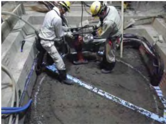
(a) ランマーによる締固め
