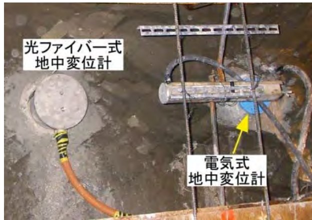
図 4.2.1.2-10 地中変位計設置状況写真
