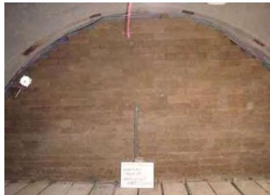
(b) 設置完了状況
