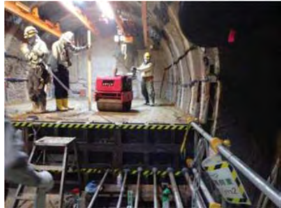
(b) ハンドガイドローラーによる締固め
