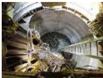
(a) 換気立坑 (H26.2.21 撮影)
