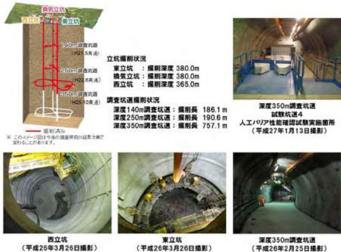
図 1.2.4-2 幌延深地層研究所の地下施設の状況
