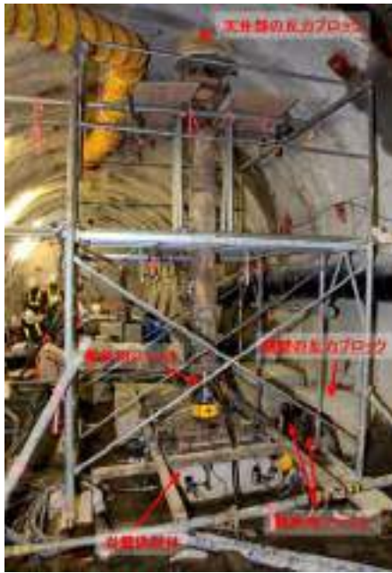
(a) 荷重試験状況
