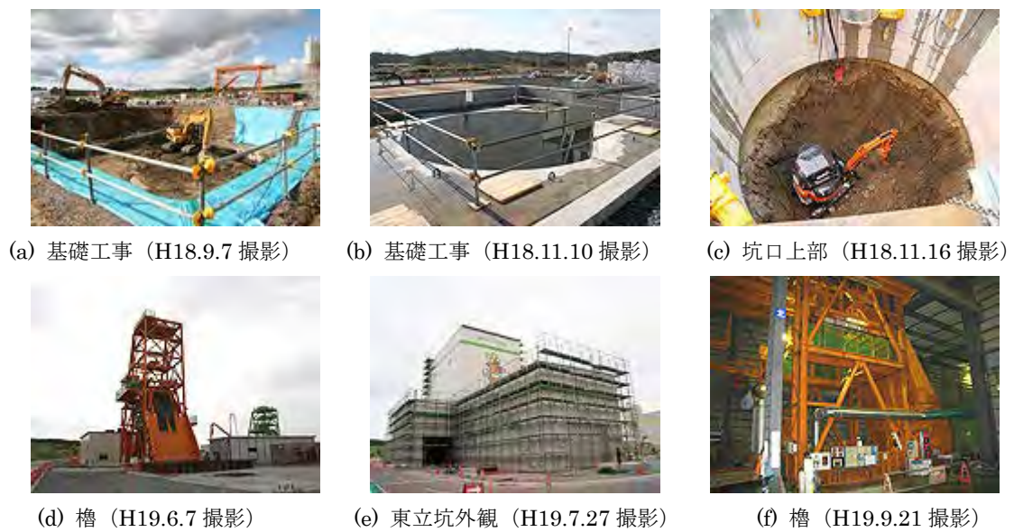
図 6.2-3 地上設備の建設状況（東立坑）
