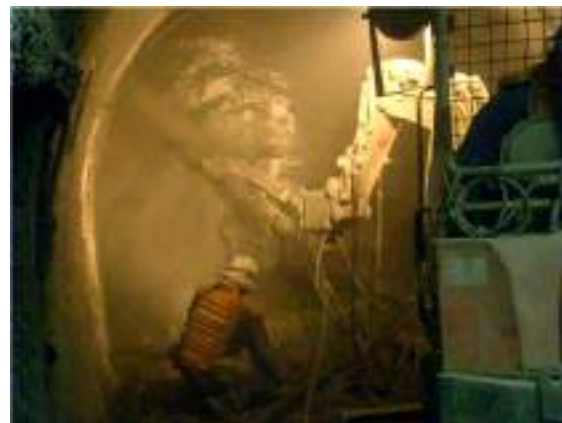
図 5.1.1-7 HFSC を用いた吹付けコンクリート 図 5.1.1-8 原位置施工試験実施状況 の原位置施工試験範囲（深度 140m 調査坑道）
