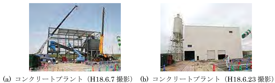
図 6.2-4 地上設備の建設状況（その他の施設）（1/2）
