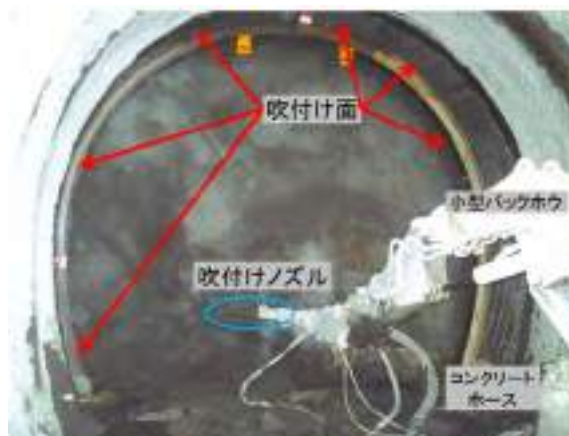
(b) 施工状況
