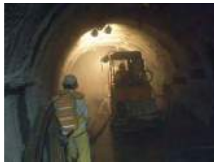
(b) 吹付け状況
