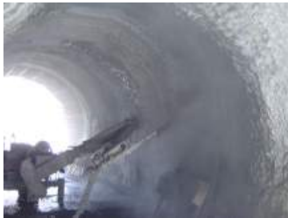
図 2.2.6-2 吹付けコンクリートの模擬施工状況
