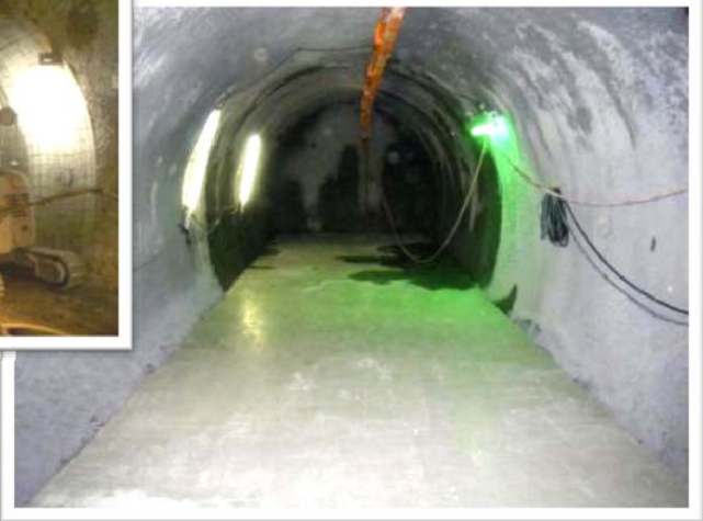
←吹付け施工の様子
