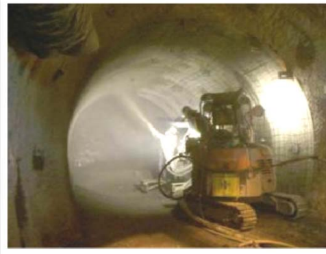
←吹付け施工の様子
