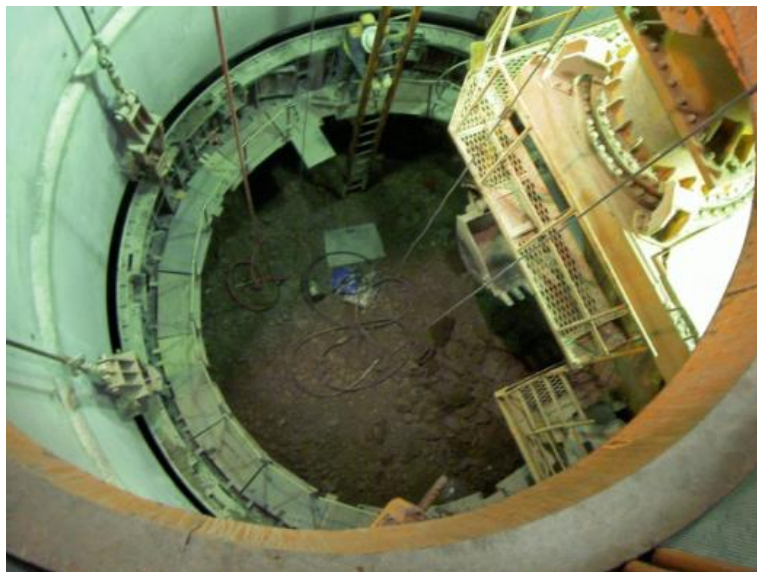
東立坑切羽部での掘削作業
