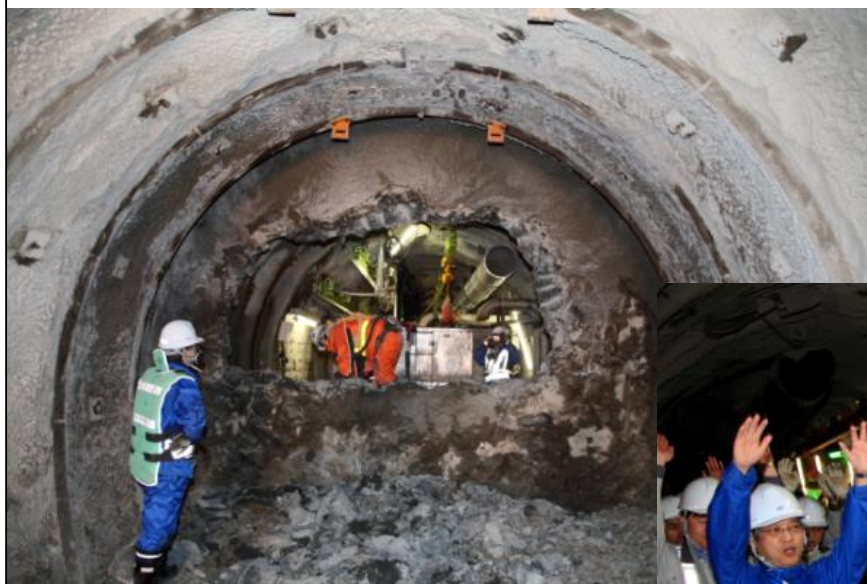
貫通した140m調査坑道（平成21年5月13日） 手前：換気立坑側、奥：東立坑側
