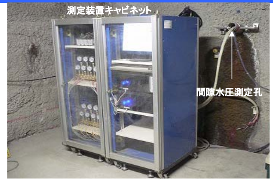
間隙水圧測定装置設置状況
