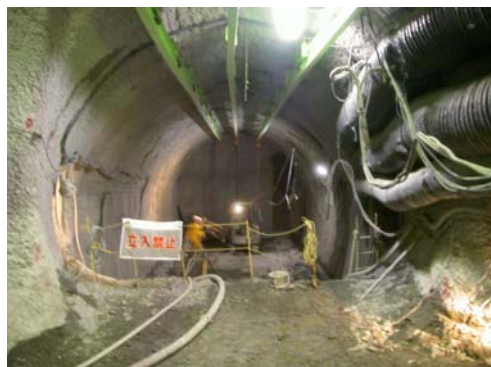
換気立坑より西方向へ掘削【大型試験座】
