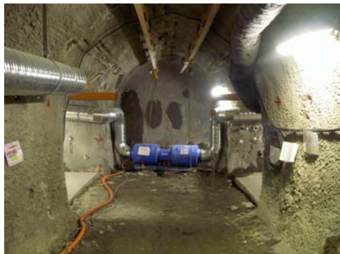
東立坑より北北西方向へ掘削
