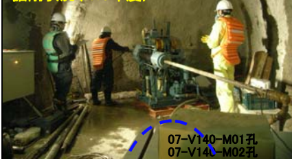
初期地圧測定用ボーリング孔掘削状況（H19年度）
