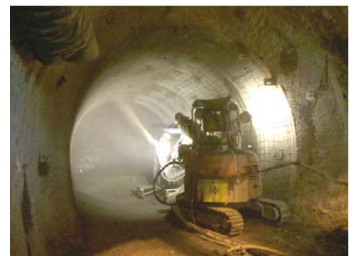
吹付け施工のイメージ (通常の吹付けコンクリート施工の様子) 33
