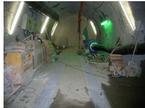
東立坑より南南東方向へ掘削【小型試験座】(南)
