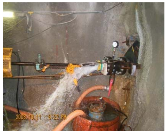
パッカー挿入作業 (湧水量: 1,200ℓ/min)
