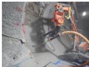
原位置吹付け試験の状況
