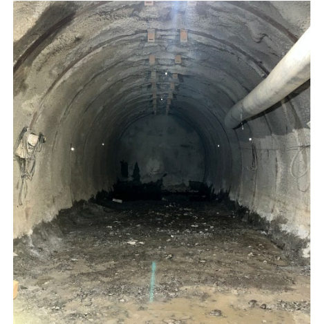
500m調査坑道掘削完了 （試験坑道8：R7.9.4）
