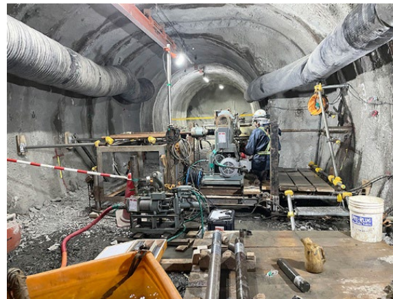
先行ボーリング掘削の様子
