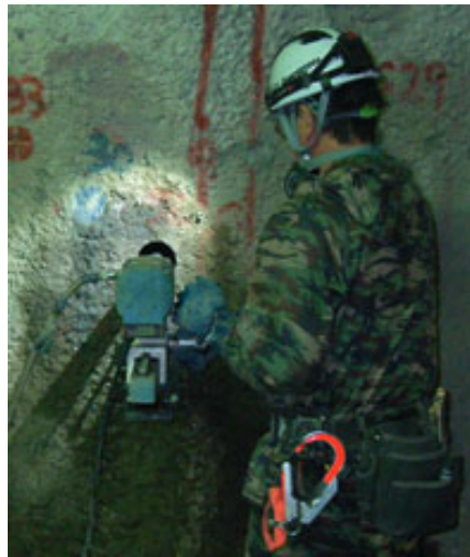
試験後のコア採取状況
