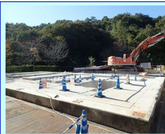
⑦受変電・非常用発電設備:完了2021.10.25
