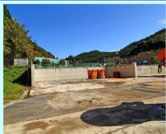
③主立坑巻上機室 :完了 2021.7.19
