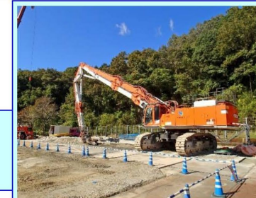
⑥コンクリートプラント :完了 2021.10.12
