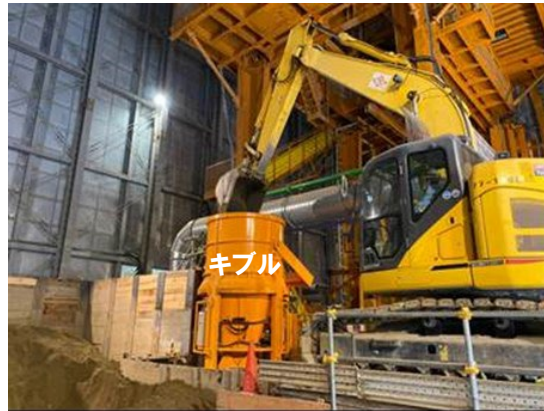
地上作業 埋め戻し材をキブル(運搬容器)へ投入 キブルを地上から立坑坑底へ檜、巻上機設備を用いて運搬
