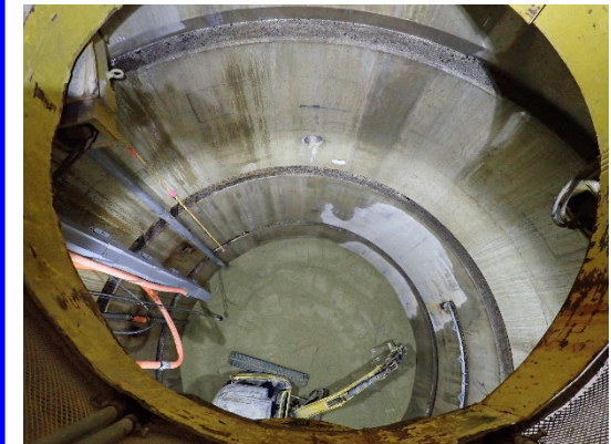
換気立坑の埋め戻し作業 深度90m付近(直径4.5m)
