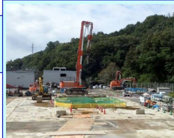
④主立坑槽防音ハウス :完了 2021.9.3
