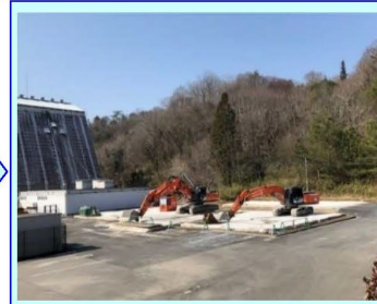
①管理棟・車庫棟 :完了 2021.2.12
