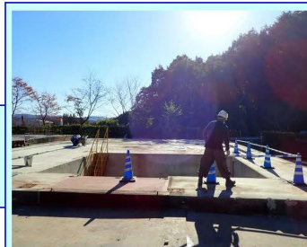
⑧換気立坑巻上機室 :完了2021.10.29
