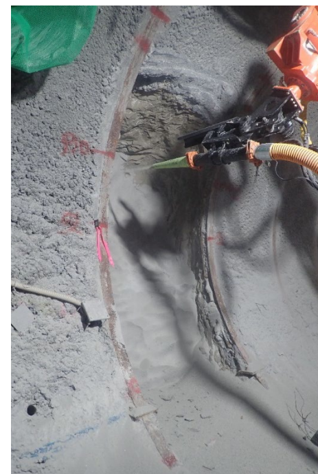
ベントナイトの吹付けによる施工方法の 工学規模試験実施状況
