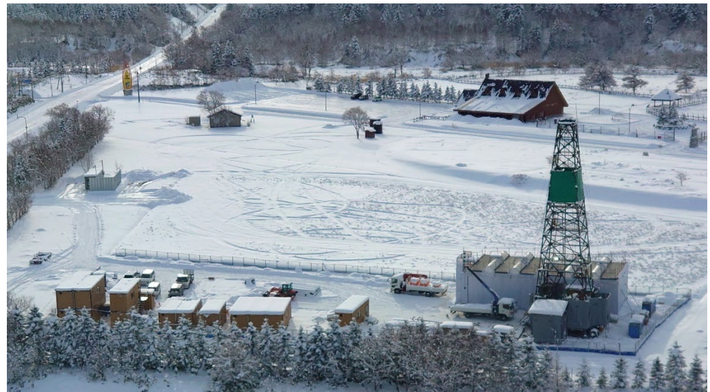
ボーリング調査現場の全景
