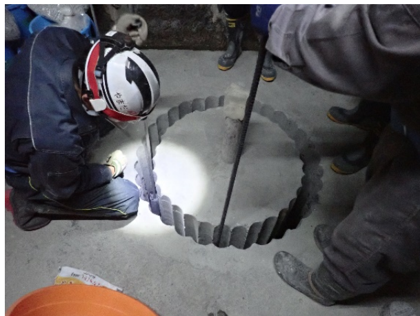
円周でくりぬいた隙間にベントナイトを充填し粘土止水壁を構築
