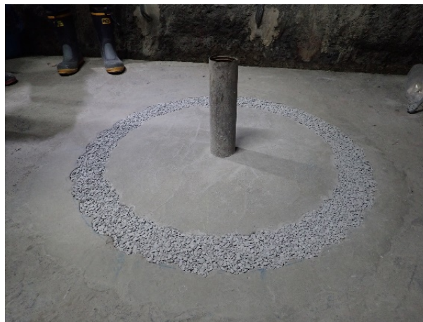
坑道床面の表面までベントナイトを充填し粘土止水壁が完成した状態
