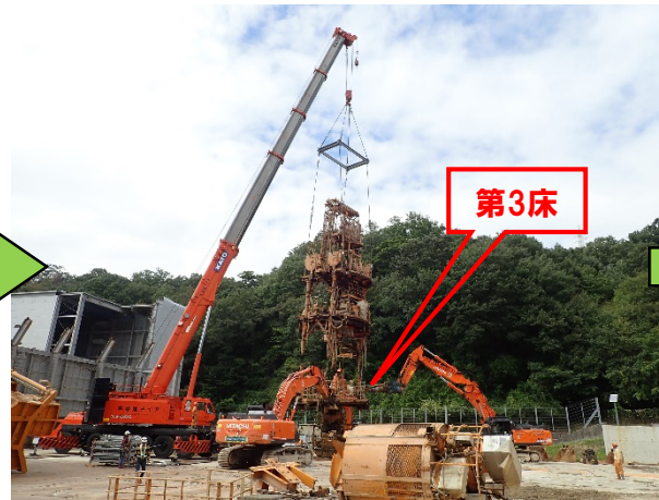
スcaffold第3床 破砕機で切り離し (切り離し後、別途地上で解体)
