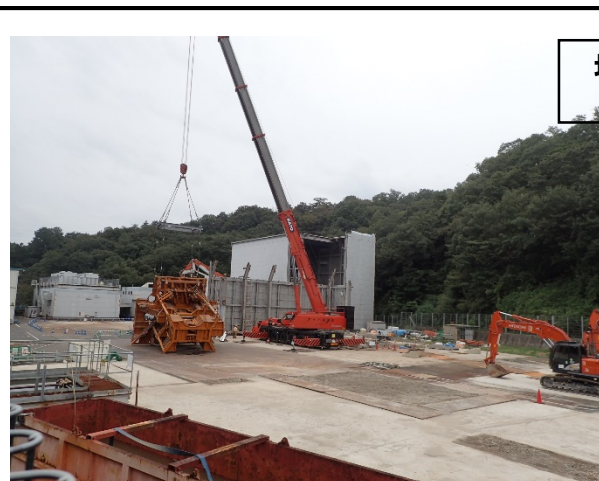
主立坑 坑口設備(坑口座張り、蓋、EV乗り場:一体物)解体作業(2021.9.14)
