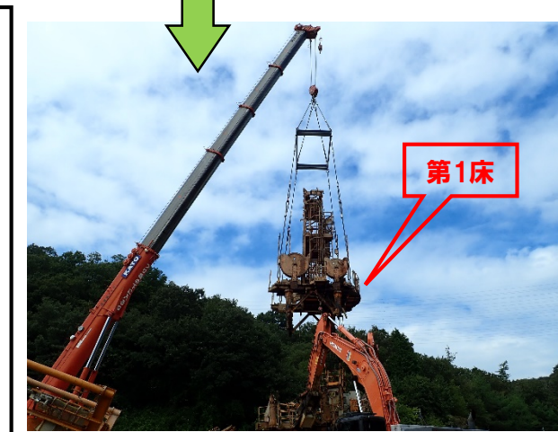
スcaffold第1床 地面に着床 (別途地上で解体)
