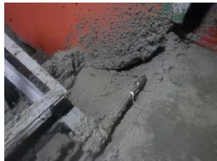
オーガ掘削(左)とウォータージェット(右)による充填材の除去状況
