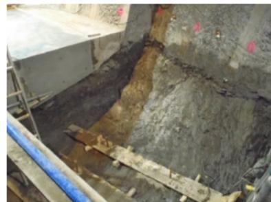
切り欠きの掘削とプラグの施工例
