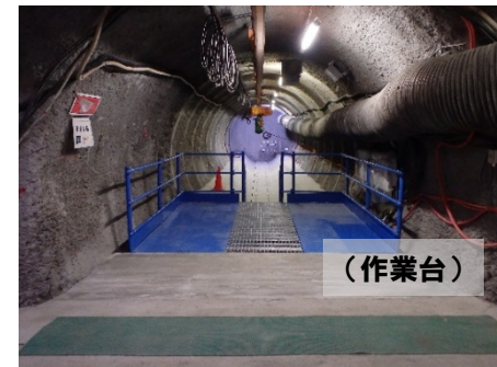
試験坑道2の整備状況
