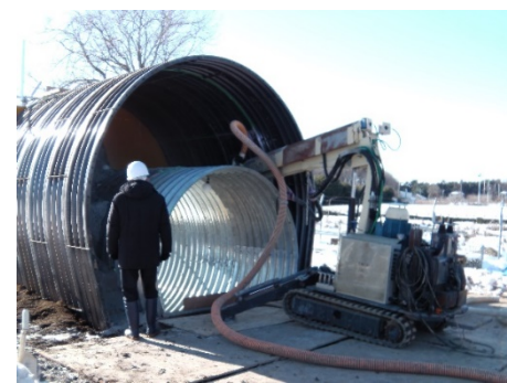
開放部の吹付け試験 地上での確認
