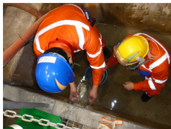
側溝の流量を測定
