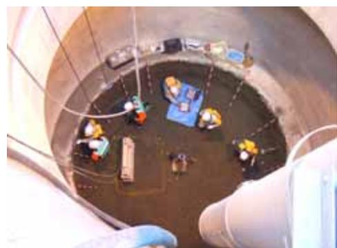
立坑壁面観測・計測状況
