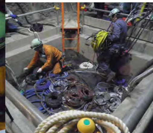
計測ケーブルの状況 (12段定置後)
