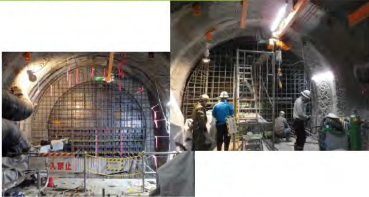
①鉄筋組立
