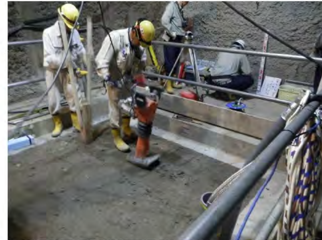
転圧締め固め
