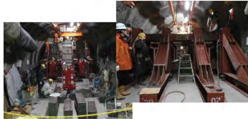
②型枠設置・控え材組立
