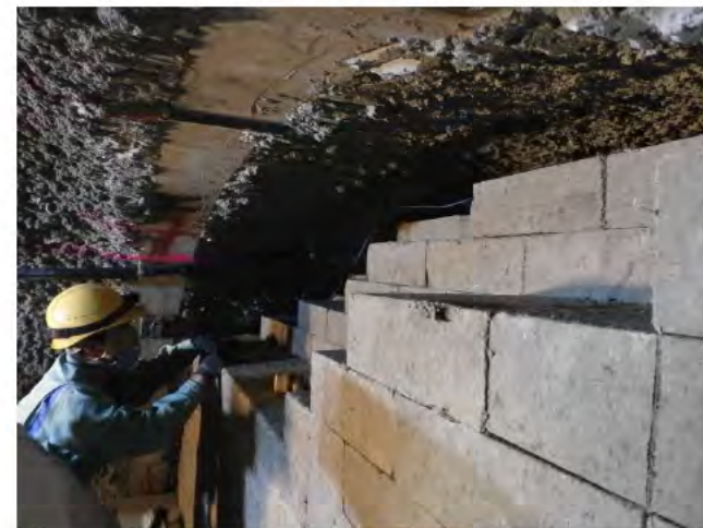
ブロック設置
