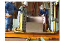
③型枠解体
