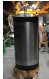
⑤組立(坑内)
