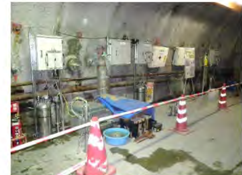
装置設置状況
