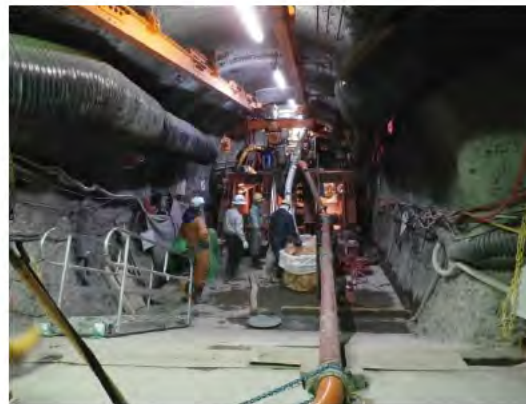
④打設状況
