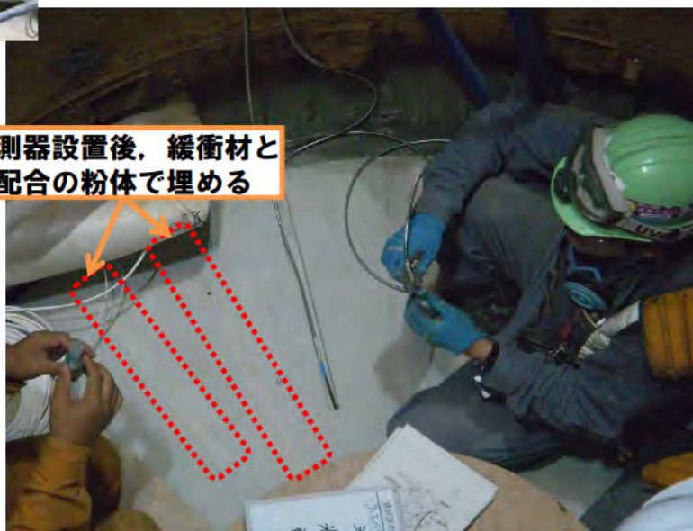
計測器設置状況
