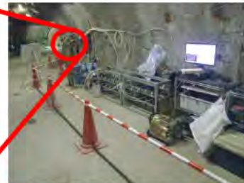
透水試験実施状況
