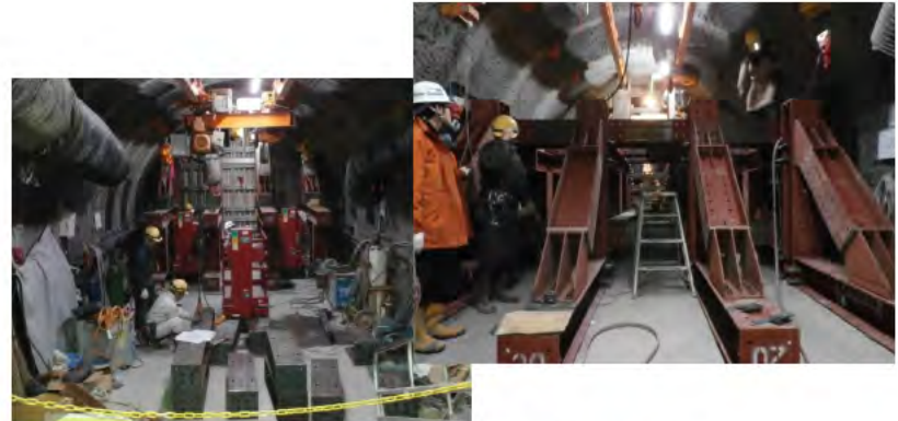
②型枠設置・控え材組立
