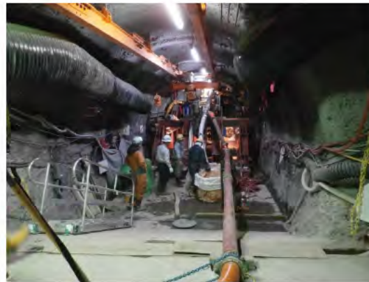
④打設状況
