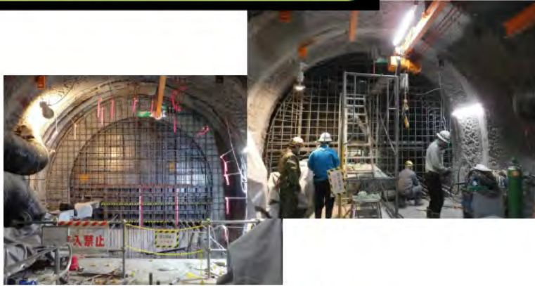
①鉄筋組立
