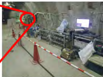
透水試験実施状況
