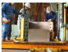
③型枠解体
