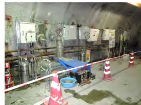
装置設置状況
