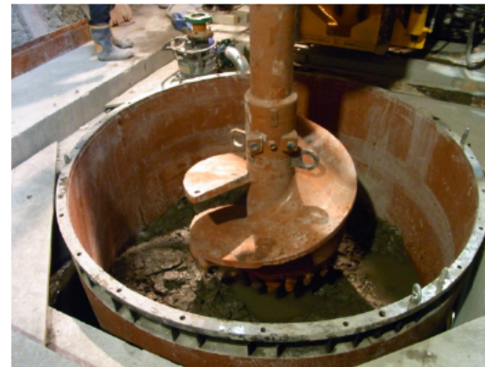
試験孔の掘削中の様子
