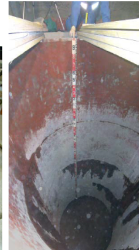
試験孔の状況 6
