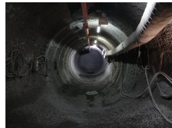
掘削状況 (試験坑道2) (平成26年1月22日撮影)
