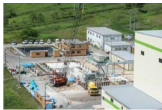
西立坑掘削工事(H23.8.12)
