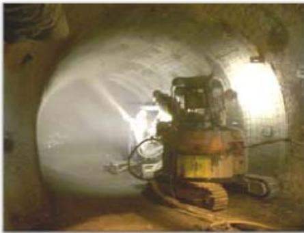
吹付け施工状況(140m調査坑道)
