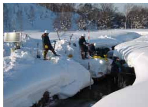
河川流量観測 (P-4観測地点の例)
