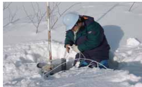
地質調査 (ガス調査) の例
