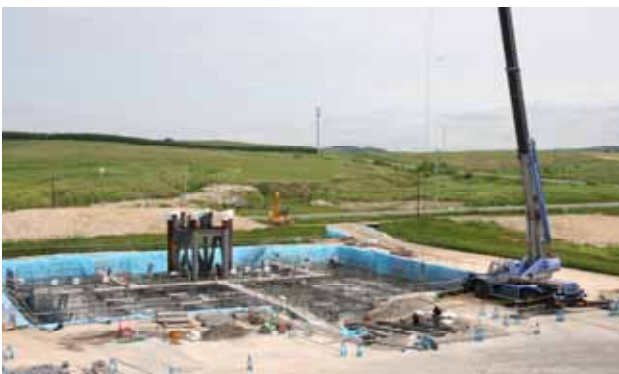
PR施設の建設状況 (平成18年7月6日撮影)
