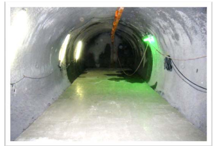
坑道仕上がり状況 (坑道支保状態良好)
