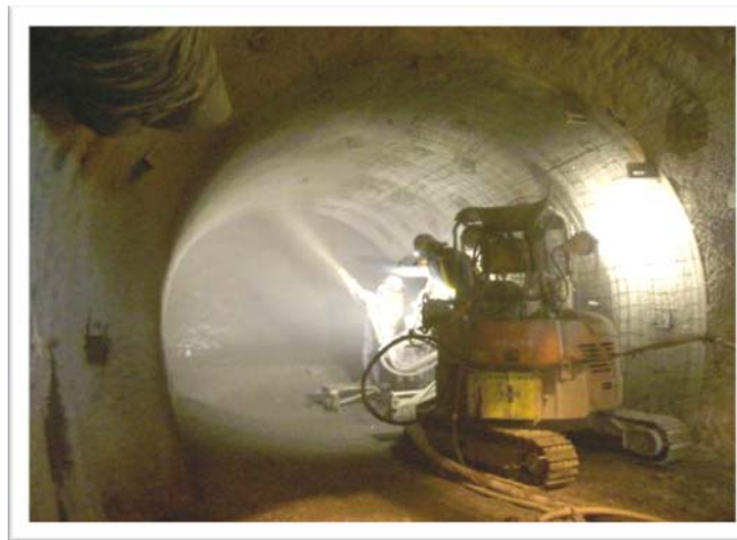
吹付け施工の様子 (粉じん・だれ・はね返り少)
