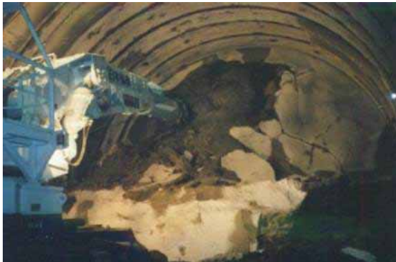
トンネル施工時の様子
